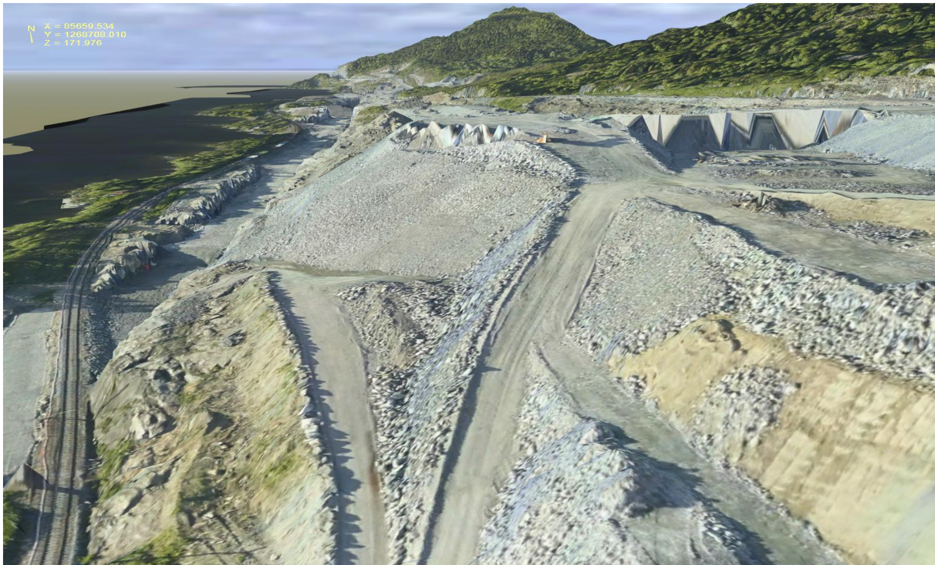
E6 Dovrebanen - Statens vegvesen/Jernbaneverket
