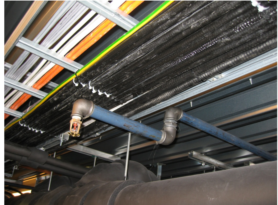
Plassering sprinklerhoder
